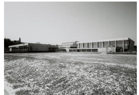
Albert-Schweitzer-Schule mit Realschule und Sporthalle nach Fertigstellung
